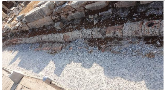
2000年前の上下水道管(表に出ているのが上水道、土に半分埋まっているのが下水道)直径は、約20cm
